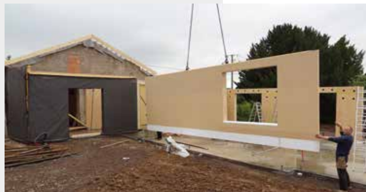
En quelques heures les murs sont positionnés.
