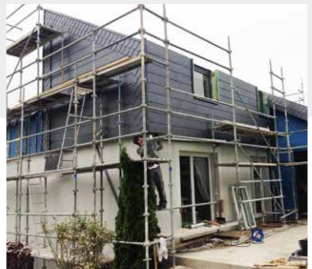
Les menuiseries posées, ne restent plus que les finitions intérieures et la VMC.
