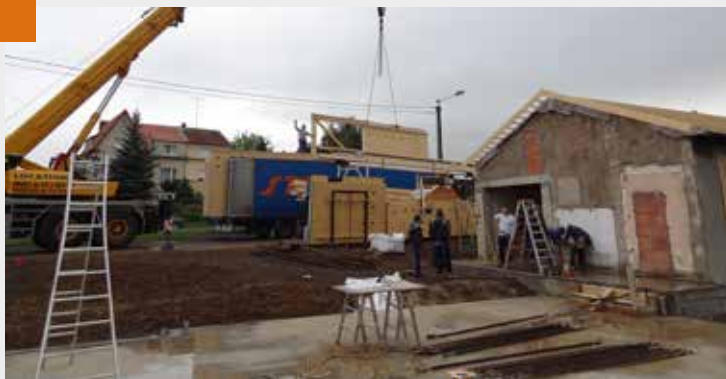
Les panneaux préfabriqués arrivent sur le chantier.
