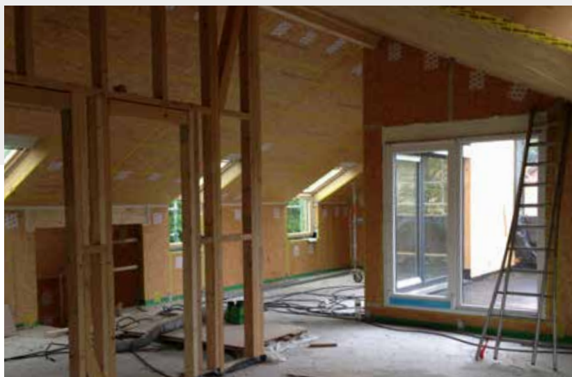
Les menuiseries posées, ne restent plus que les finitions intérieures et la VMC.
