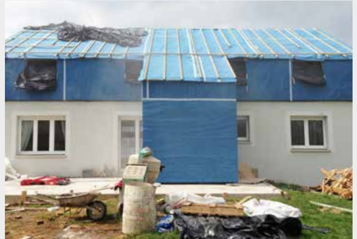
La nouvelle charpente hors-d'eau !
