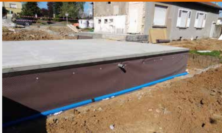
Dalle de la future extension.
