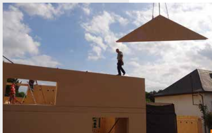
Pose du pignon.
