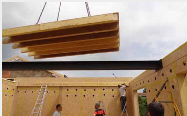
Pose du plancher de l'étage.
